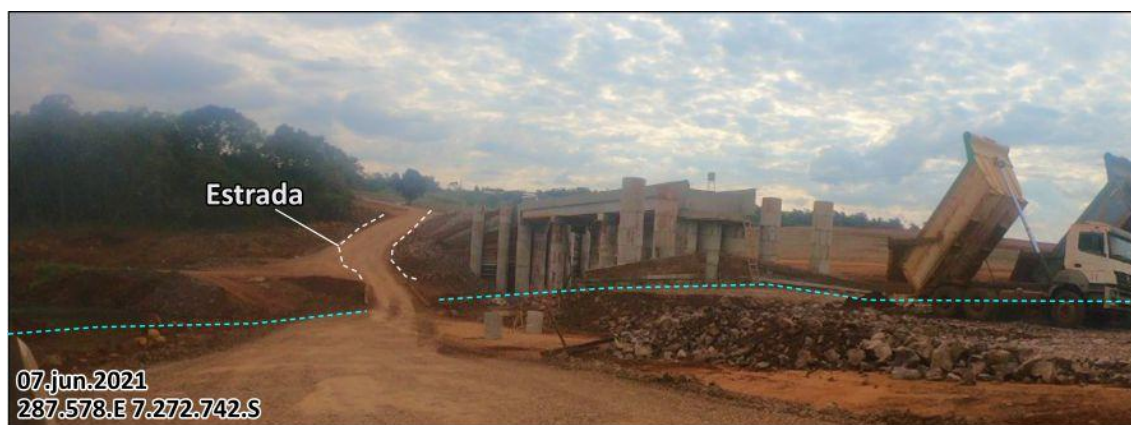
Figura 68 – Estrada e antiga ponte nas margens do rio Sapucaia antes do alagamento.
