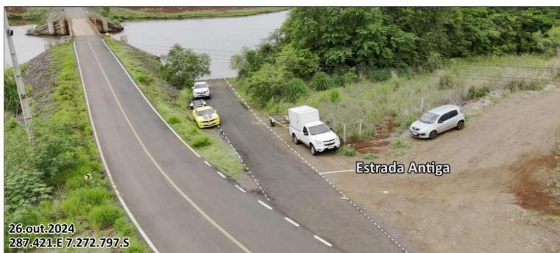
Figura 69 – Estrada da ponte submersa que foi revitalizada em 2024 pela prefeitura de Anahy.
