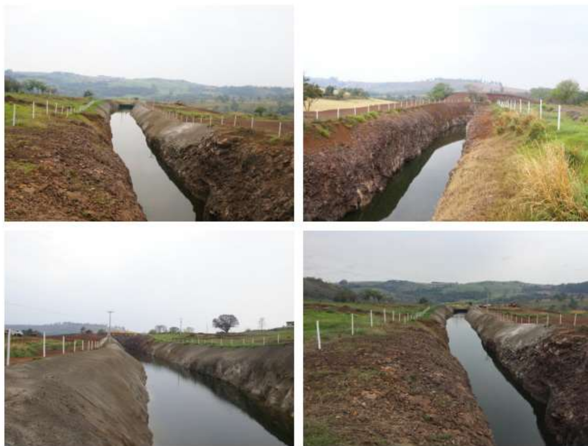
Figura 19 - Cercamento ao entorno do canal adutor.
