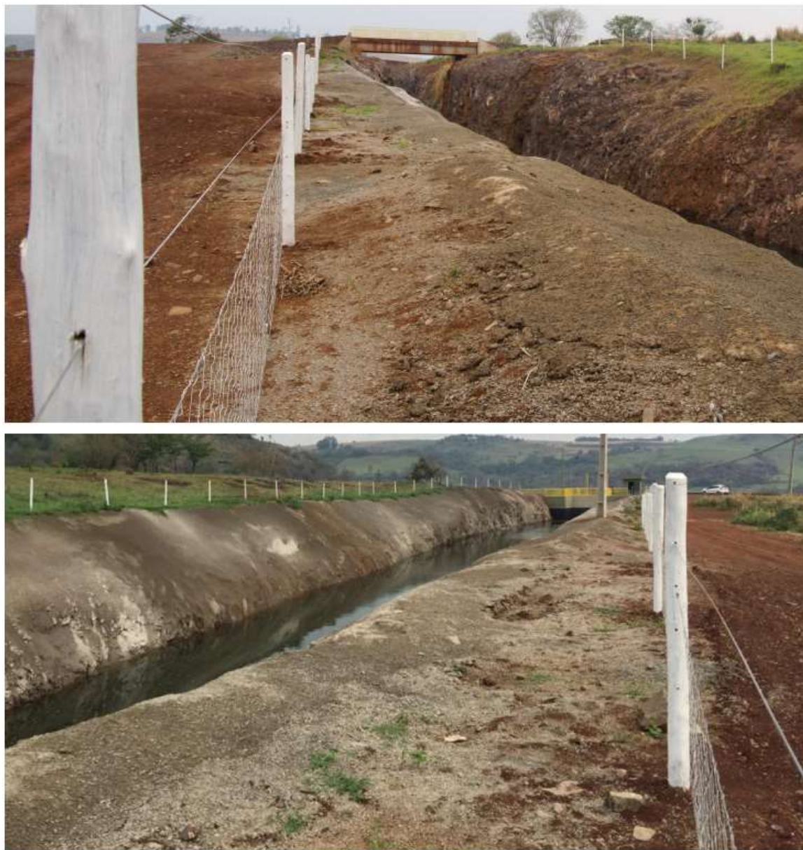
Figura 20 – Metodologia de cerramento evidenciando a tela e fios arame liso.
