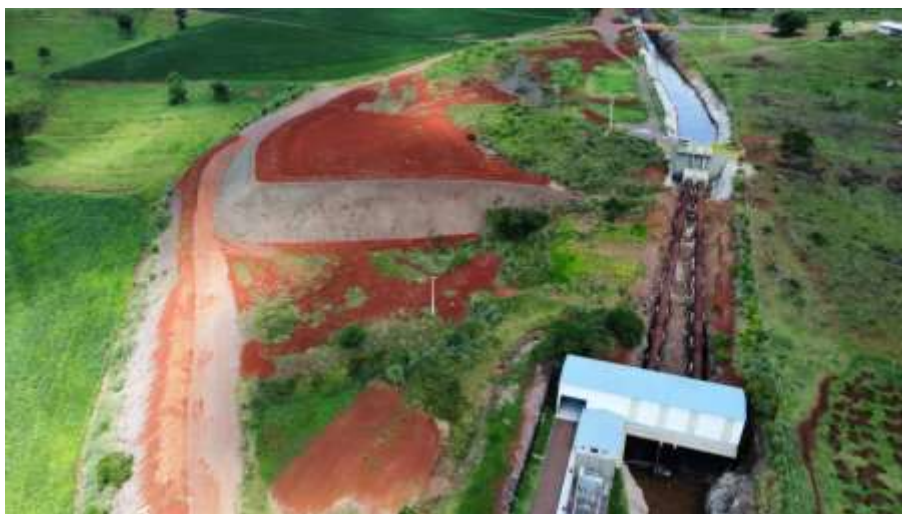
Figura 23 - Aplicação de hidrossemeadura em taludes do bota fora - 12/2022.
