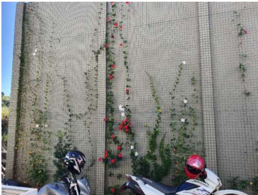
Figura 25 - Recuperação de área entorno da casa de força.
