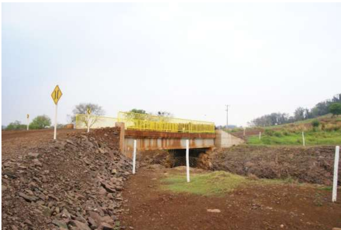
Figura 21 - Ponte de transposição do canal adutor.
